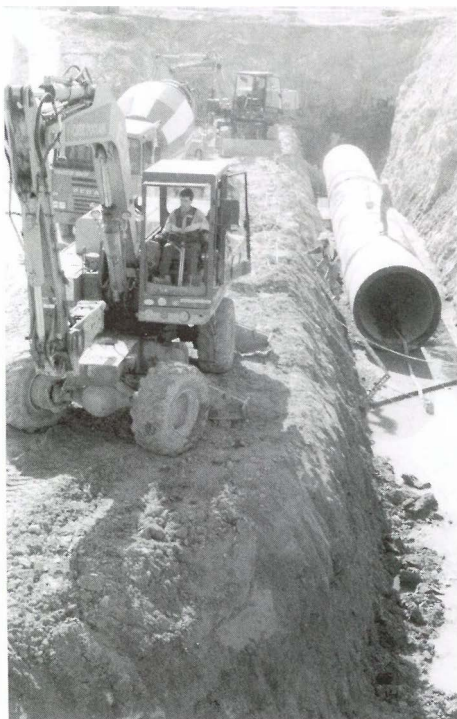
Se recuperará un antiguo vertedero situado en el Polígono de los Gavilanes
