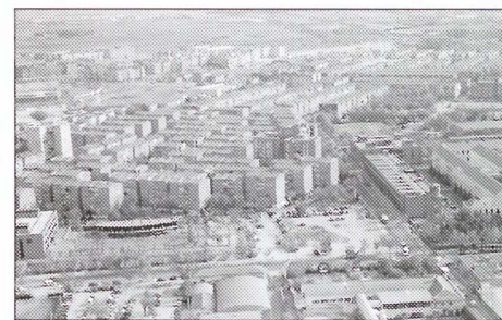
En la imagen aérea, el barrio de las Margaritas, cuya remodelación parcial (Avda. de las Ciudades) se llevará a cabo.
