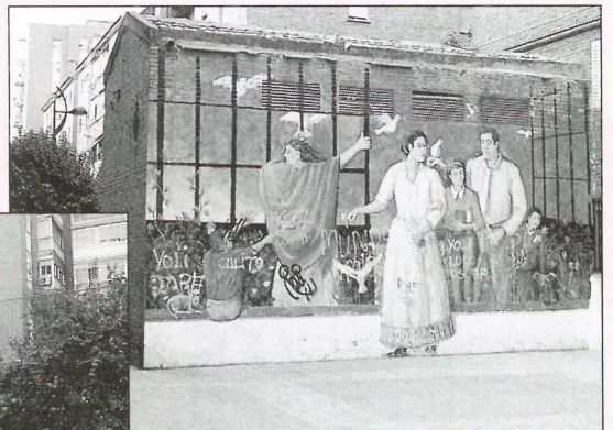
Imágenes de los distintos transformadores eléctricos de Getafe.
