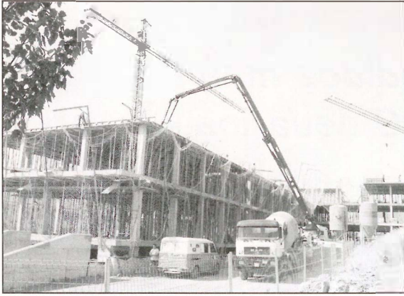
Estado actual de la Residencia Geriátrica Ntra. Sra. de los Ángeles.
