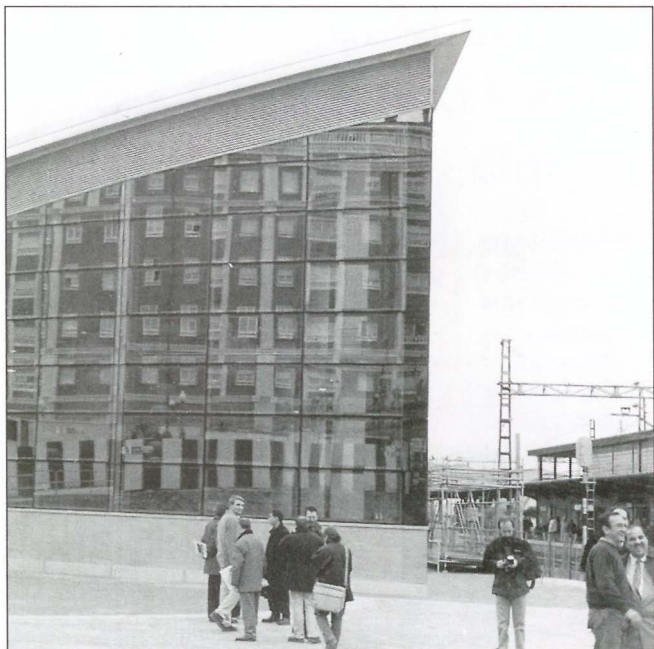
Estación Getafe Centro.
