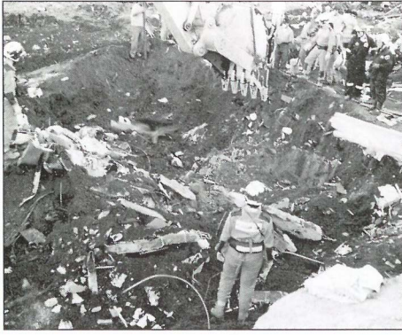
Trabajos de búsqueda de supervivientes tras el terremoto.
