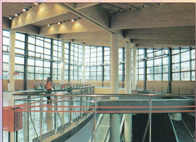
Uno de los aspectos que más destacan de la nueva estación es su luminosidad.
