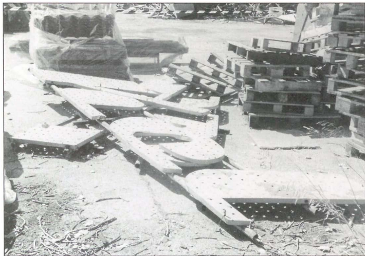
El derribo de Kelvinator cierra una página de la historia de Getafe y da paso a un moderno barrio
