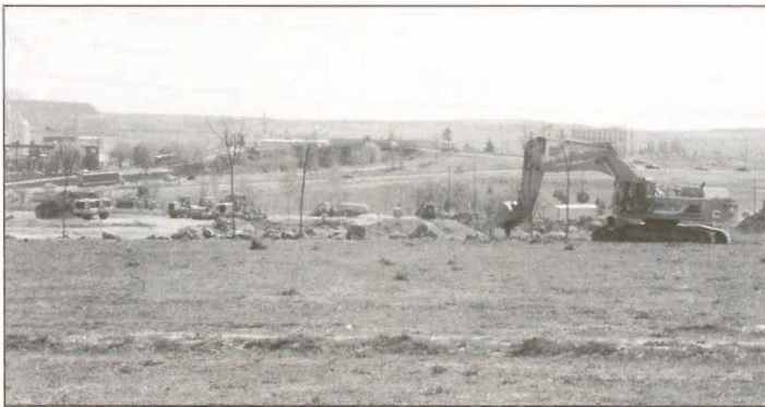
Las obras del Parque de Ocio Andalucía, a buen ritmo.
