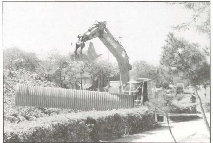
Los nuevos colectores son la solución al problema de Las Laderas.
