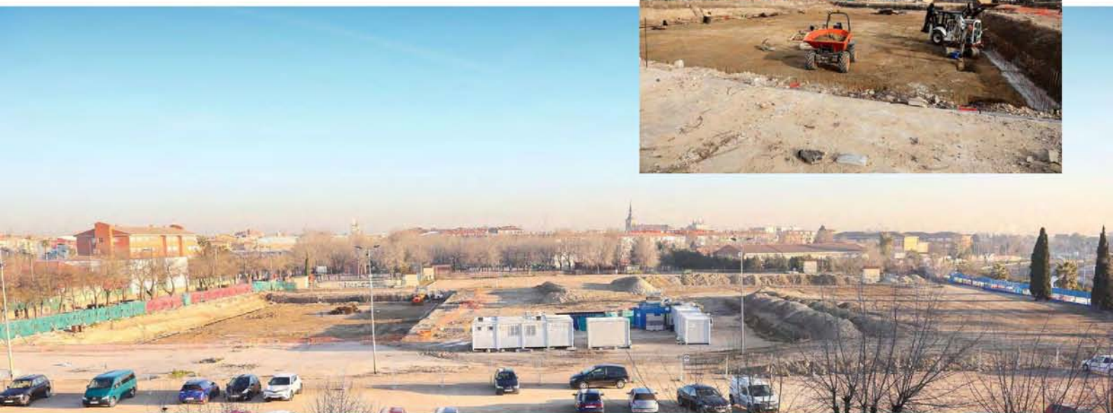
▲ La primera fase del Polideportivo de San Isidro avanza con la cimentación del edificio que albergará el complejo acuático y las salas polivalentes
