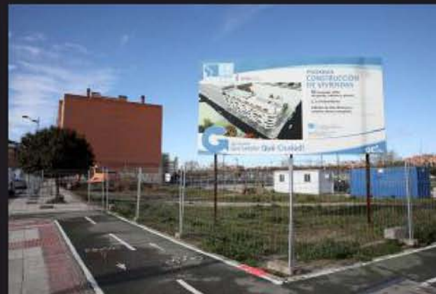
EN MARCHA LAS OBRAS PARA 147 VIVIENDAS PÚBLICAS
