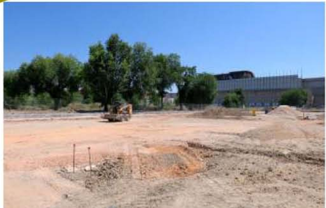
OBRAS EN LA ZONA DE APARCAMIENTO
