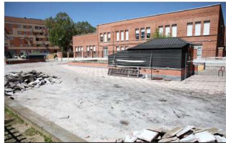
OBRAS DE LA PLAZA LANZ IBÉRICA
