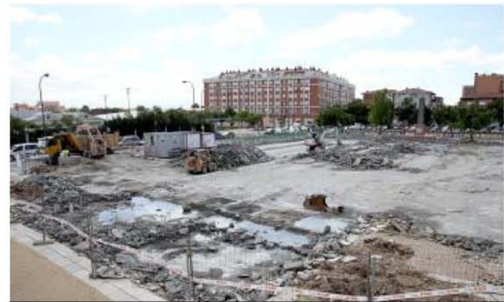
OBRAS EN LA PLAZA JUAN VERGARA
