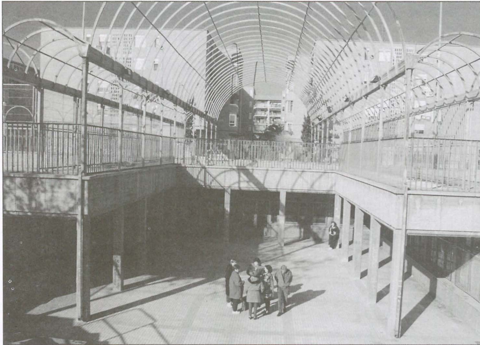
La ampliación del Centro Cívico de Juan de la Cierva tiene un plazo de ejecución de 12 meses.
