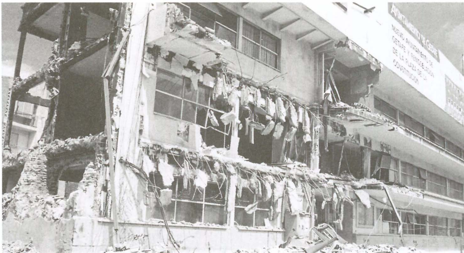
Tras el verano comenzará la construcción del nuevo edificio
