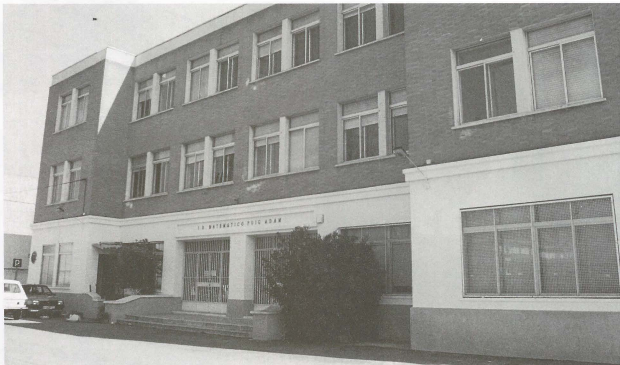
En el instituto Puig Adam se han instalado dos contenedores de papel
