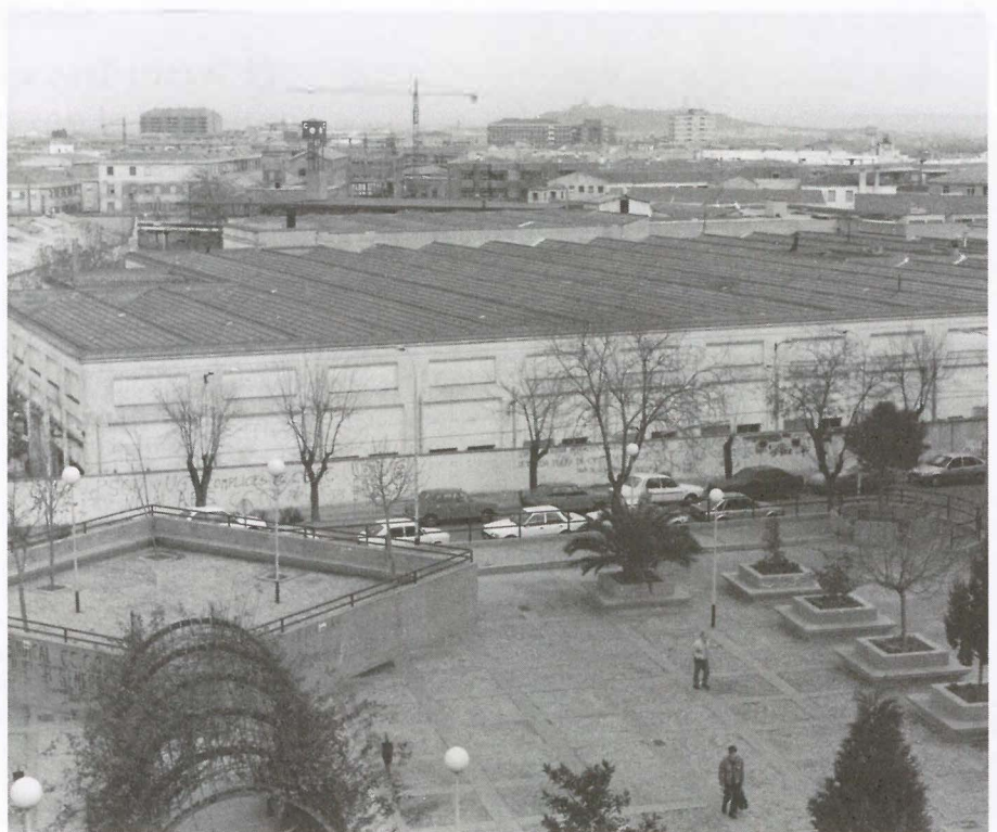
245 nuevas plazas en el barrio de la Alhóndiga
