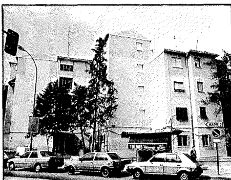
Edificio rehabilitado en lo que se conoce como "Casa de los Sindicatos".
