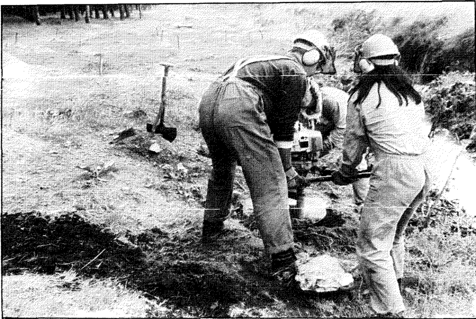
Estaquillado y realización de hoyos del área a recuperar.
