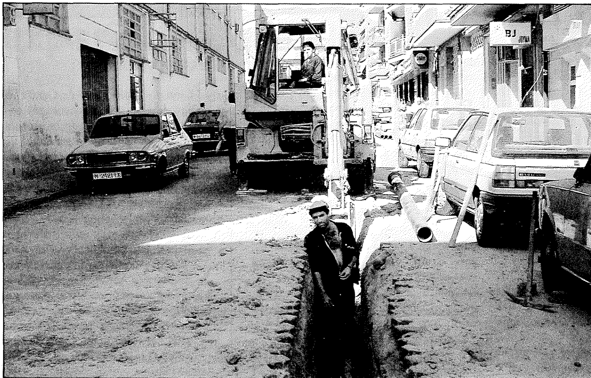
La Canalización del Gas Natural en Getafe hace necesario primero obras en la calle, segundo obras en el inmueble y tercero obras en el hogar.
