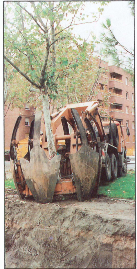
Distintas fases del trasplante de árboles mediante un sistema utilizado por primera vez en nuestro municipio.
