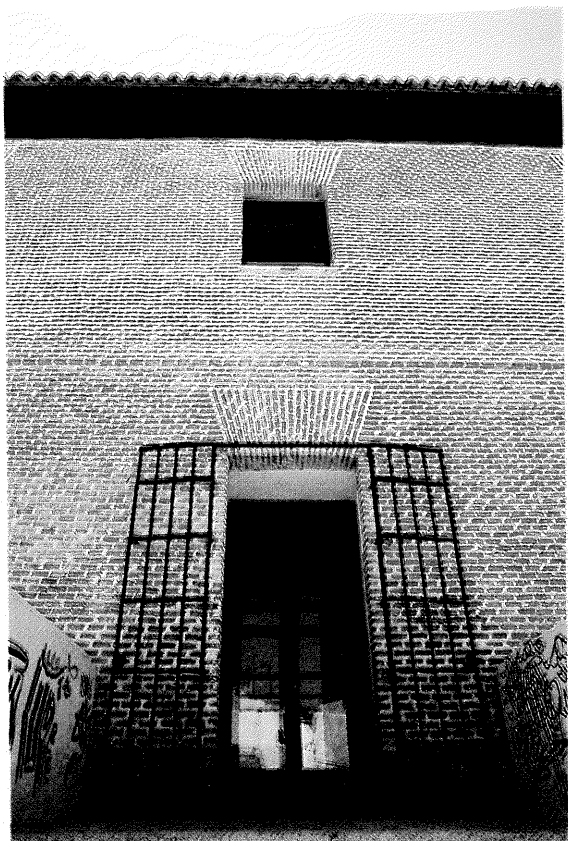
El ladrillo visto es la base de los potentes muros del edificio
