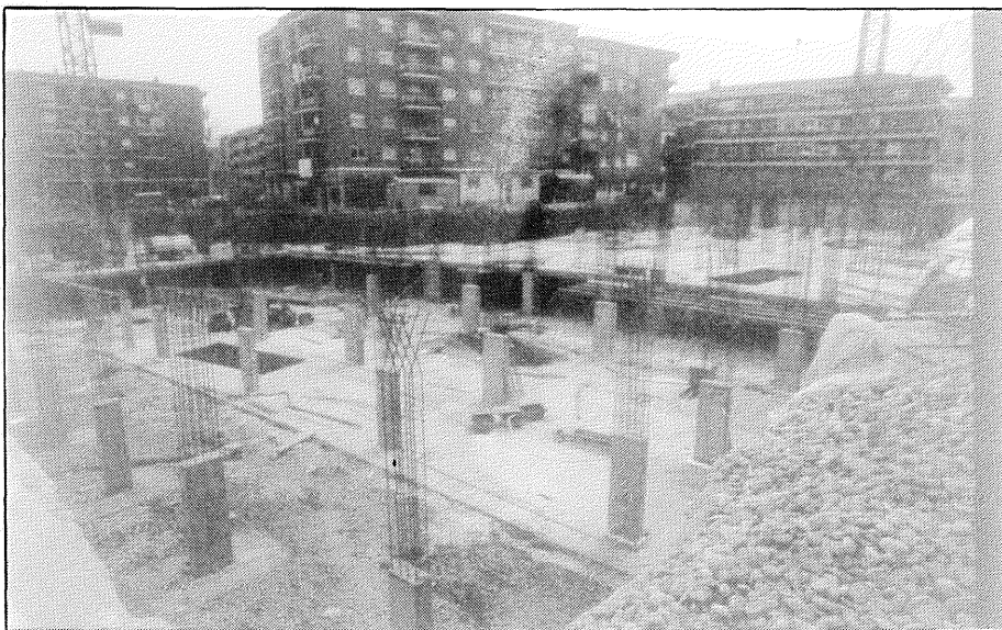
Dos nuevos aparcamientos subterráneos se empezarán a construir en breve plazo para paliar el problema del aparcamiento
