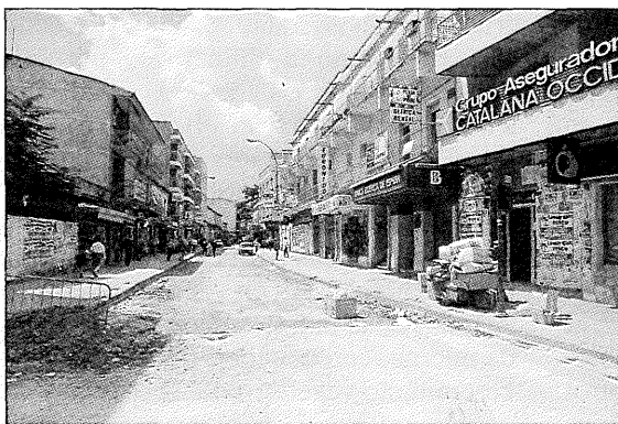
Las obras de peatonalización de la Calle Madrid comenzaron en la Plaza del General Palacios y en el curso de seis meses toda la calle será peatonal definitivamente.
