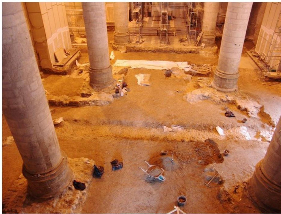
TAPANDO LAS EXCAVACIONES REALIZADAS...
