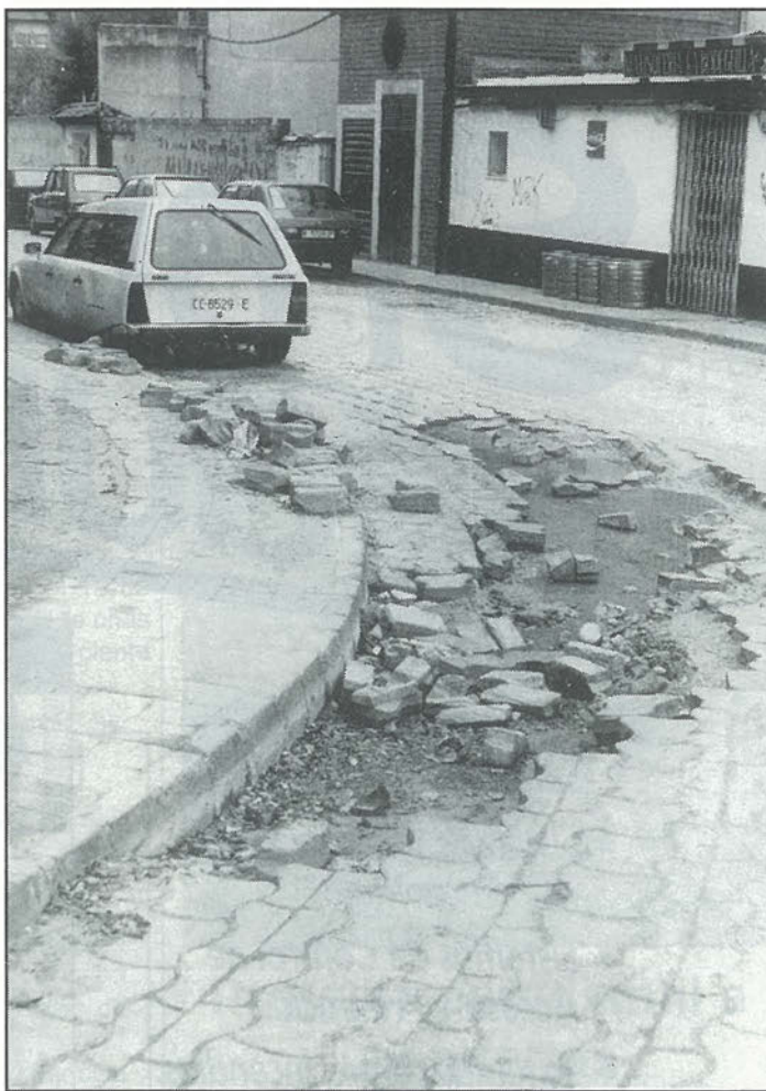
El Canal y el IVIMA no se ponen de acuerdo y la calle sigue en obras. Foto: Miguel Martín.
