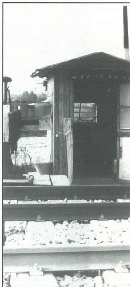
RENFE inicia remodelación de instalaciones. Foto: Noé Mora.
