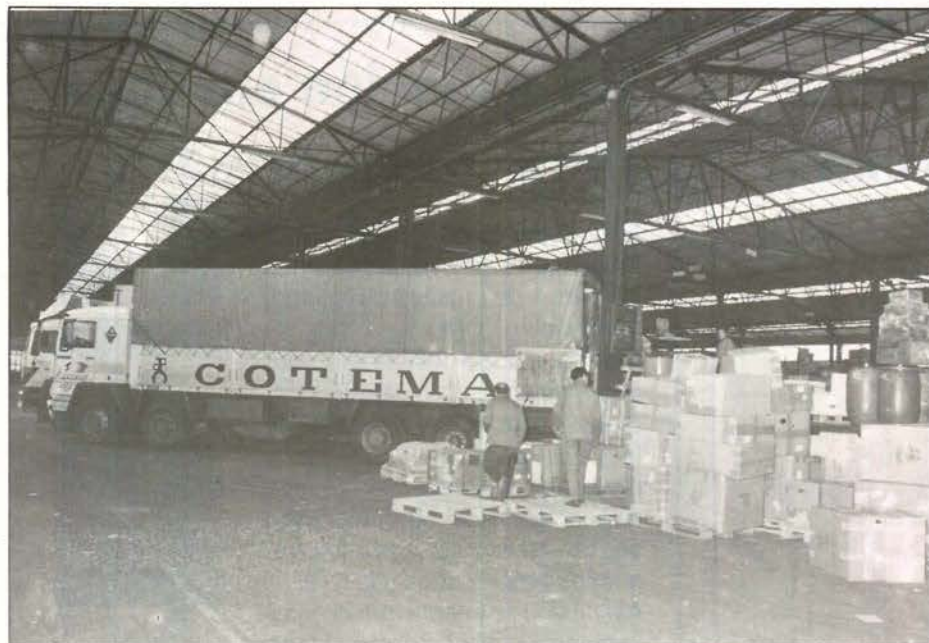
Vista panorámica de las instalaciones de COTEUR.
