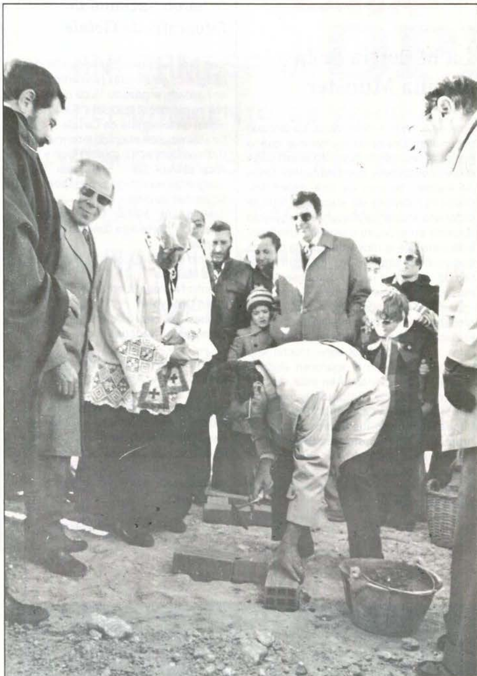
Colocación del primer ladrillo para el futuro edificio de Apanid.
