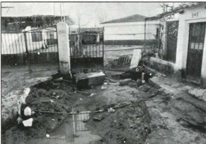
El agua causó importantes destrozos.
