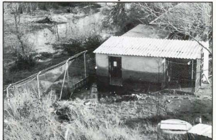
Las casas estuvieron parcialmente cubiertas durante las inundaciones.
