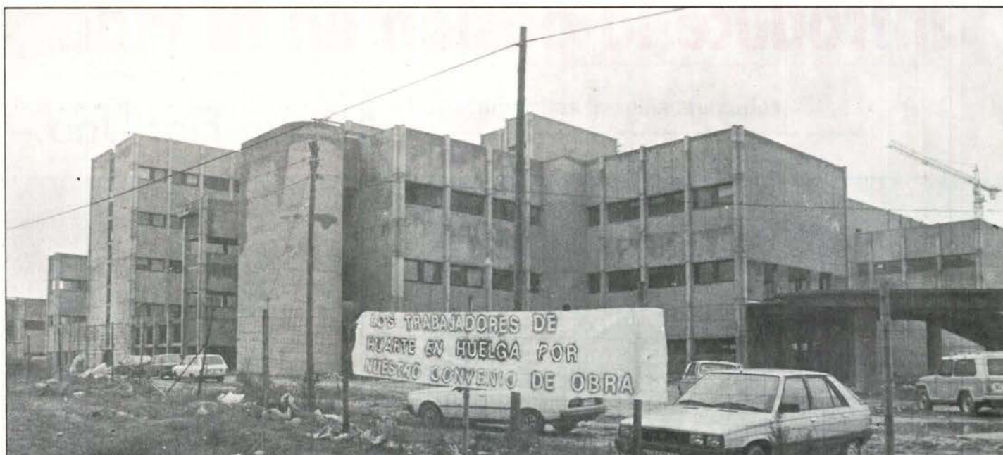
El ritmo de las obras se ha visto entorpecido por las lluvias caídas durante las últimas semanas
