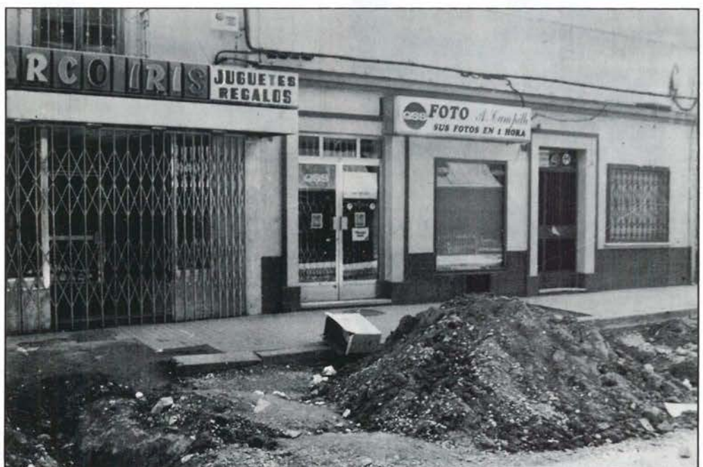
La solución de urgencia buscada consiste en hormigonar la calle.
