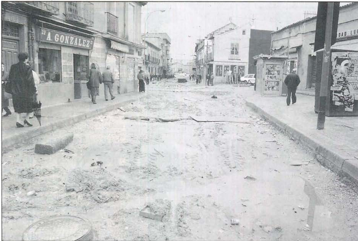
La calle Madrid se ha convertido en una vía intransitable.
