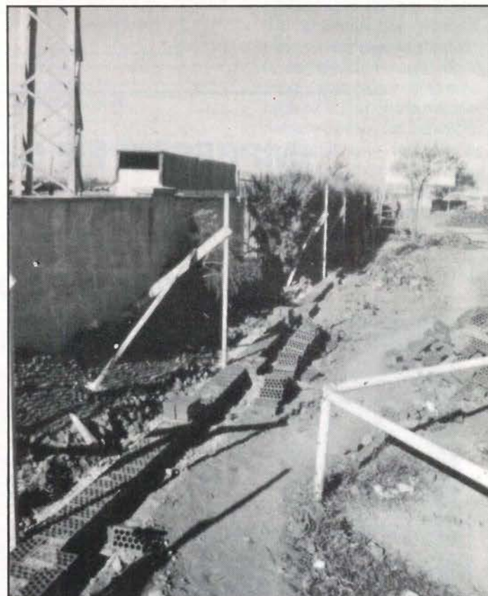
Las fotografías demuestran la construcción de una valla nueva unos metros más retrasada.
