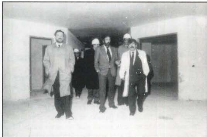
Francisco Ortega durante una visita a las obras del hospital
