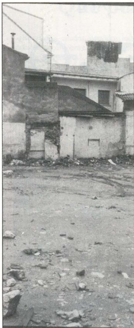
El suelo en Getafe se revaloriza continuamente
