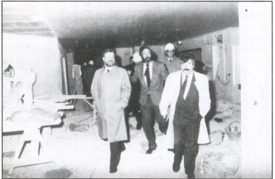
Francisco Ortega observa el curso de las obras acompañado por Pedro Castro.
