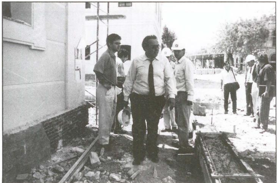
Gregorio Peces Barba observa la marcha de las obras.
