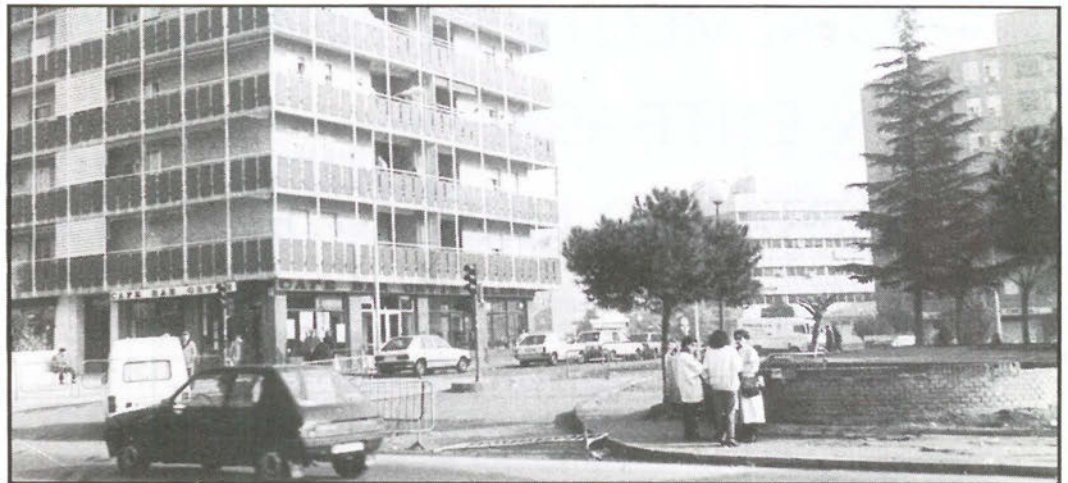
Obras del nuevo carril para acceder a la plaza de España
