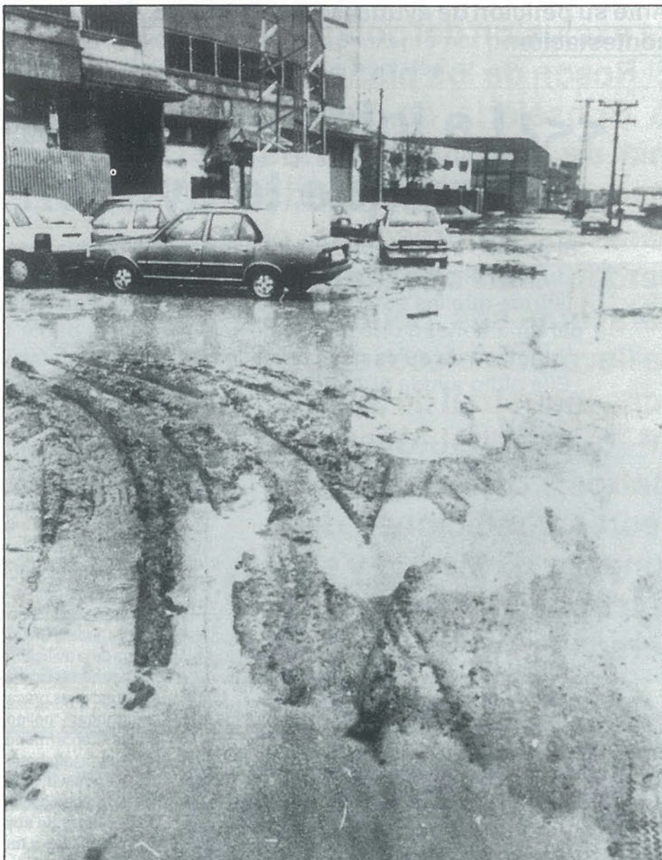
La lluvia acrecienta el mal estado del Polígono El Rosón. Foto Miguel Martín
