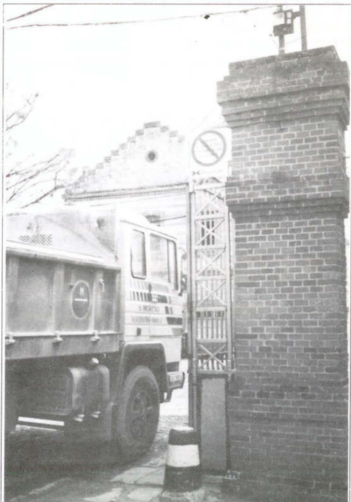
Obras para la restauración del antiguo Acuartelamiento Elorza
