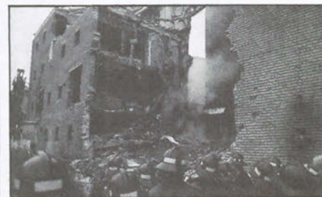
Aspecto de la casa-cuartel de la Guardia Civil en Zaragoza tras el atentado perpetrado por ETA el pasado viernes, 11 de diciembre, que causaba 11 muertes, entre ellas las de 5 niños.
