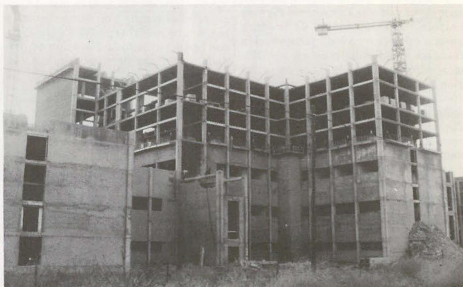
La ampliación de volumen necesaria para la integración del hospital central de la Cruz Roja en el hospital de área de Getafe, se alcanza mediante la elevación de dos plantas en avanzado estado de construcción. La modificación arquitectónica también contempla el acoplamiento de módulos agrupados según su naturaleza a lo largo de las dos grandes galerías de circulación.
