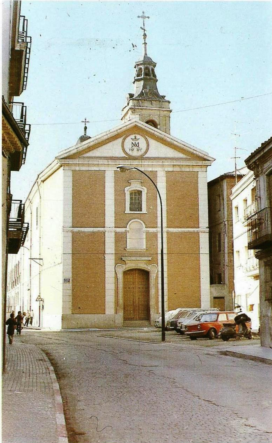
Fachada de la iglesia de los Escolapios
