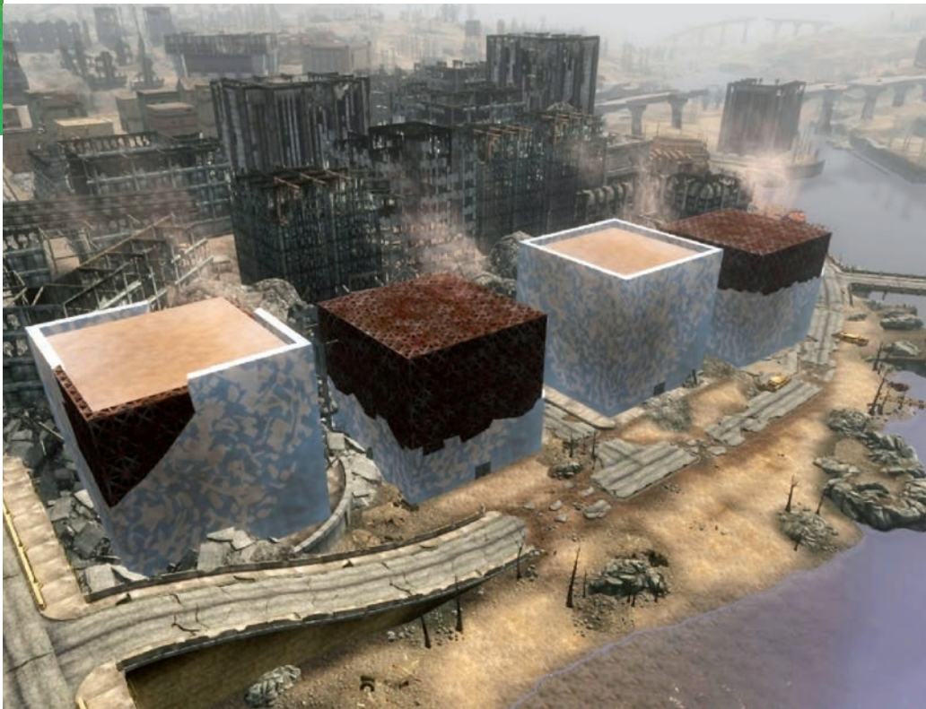
Representación digital del estado actual de la Central nuclear de Fukushima I. Se aprecian los desperfectos provocados por las explosiones de los reactores 1, 3 y 4.
