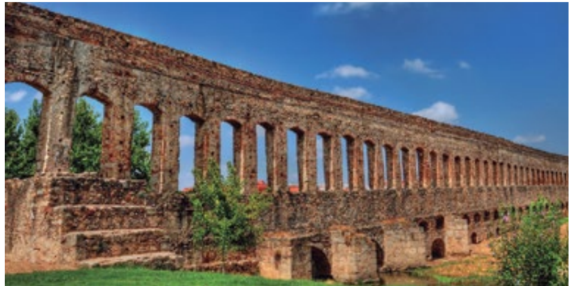
Acueducto de San Lázaro.
