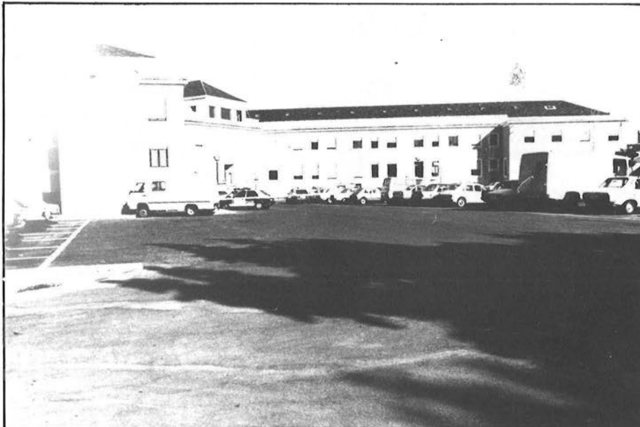
En el patio del cuartel también se levantará el futuro Palacio de Justicia
