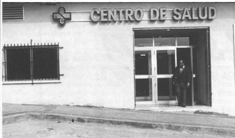
Fachada del recién estrenado centro de salud de La Fortuna.
