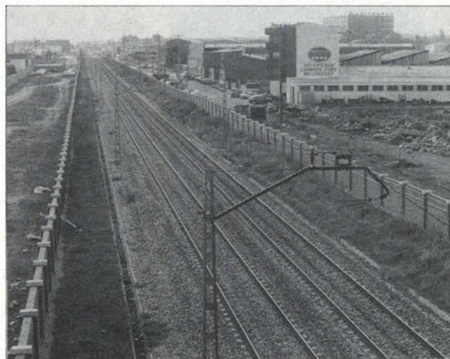
Aspecto de la vía del tren a su paso por Getafe.
