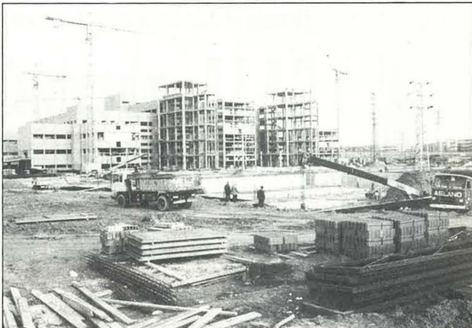
Obras del futuro Hospital Central de Getafe.
