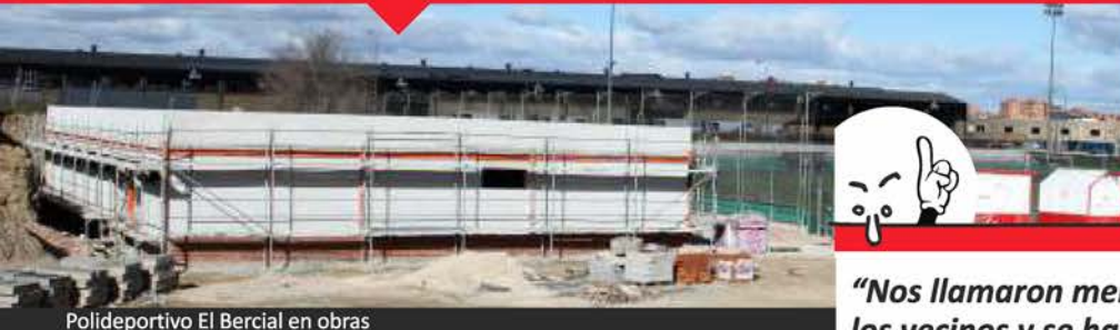
Polideportivo El Bercial en obras
