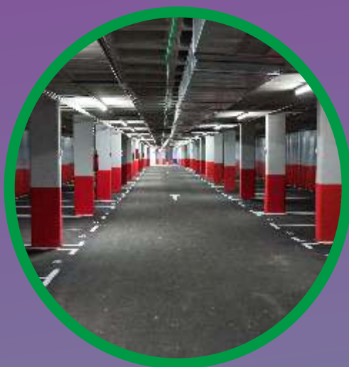
Mantenimiento integral de aparcamientos
