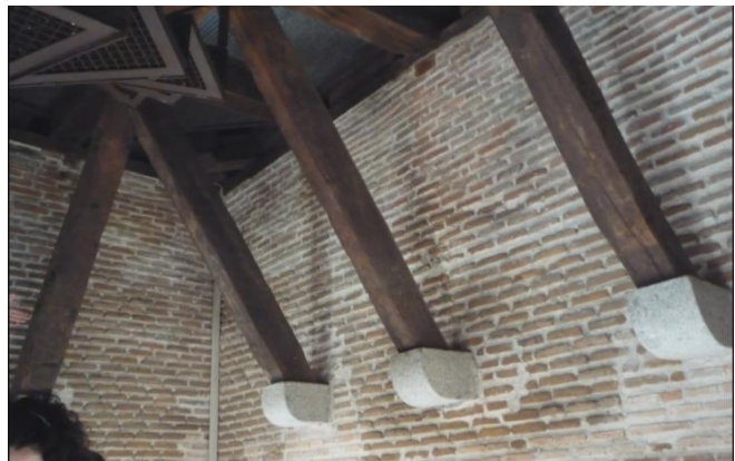
Fotos de los jabalcones y ménsulas del chapitel
