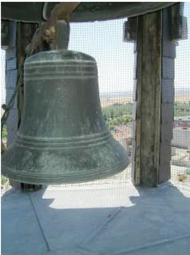
La campana de CUARTOS situada debajo de la de HORAS. Ambas funcionan con electromazos
