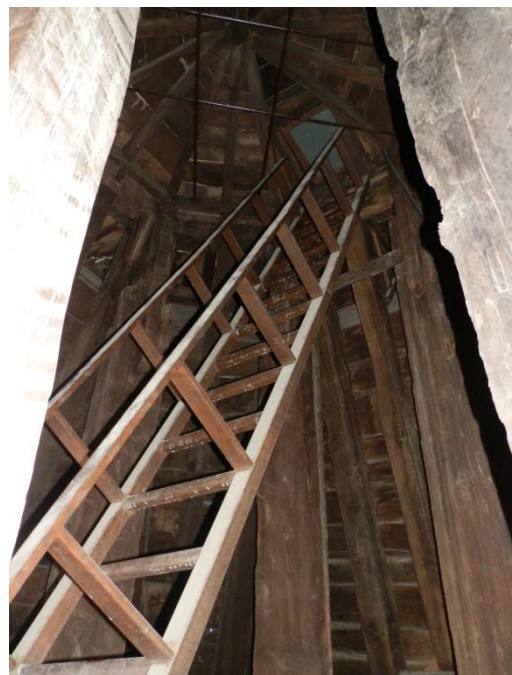
Escalera del interior del chapitel
