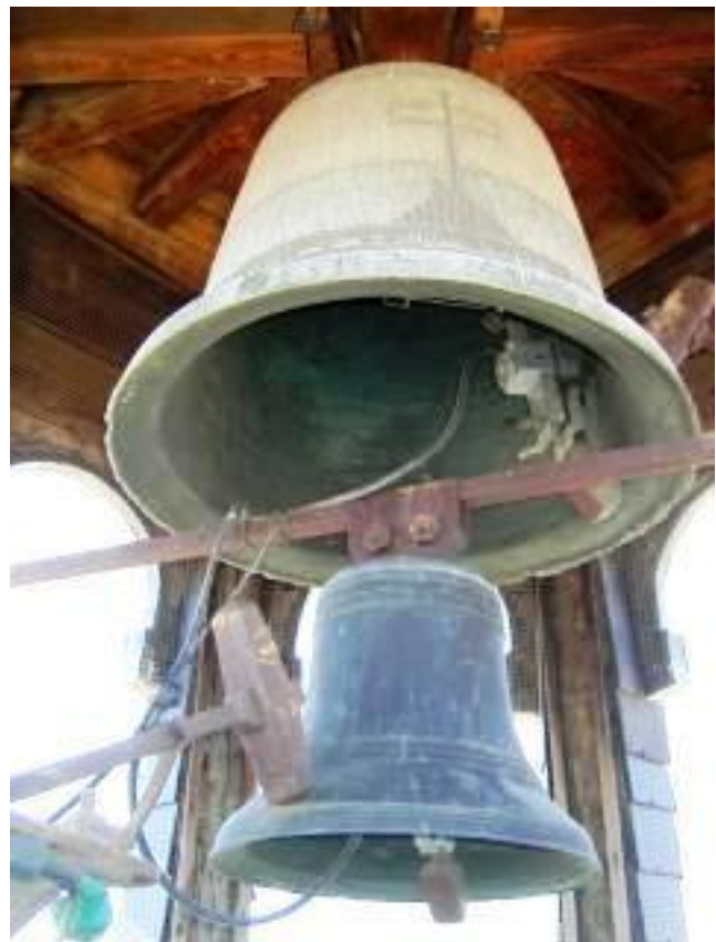
La campana de CUARTOS situada debajo de la de HORAS. Ambas funcionan con electromazos
