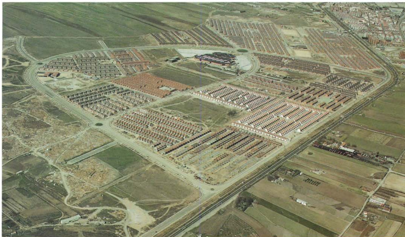
Vista aérea del Sector 3 en fase de construcción.
