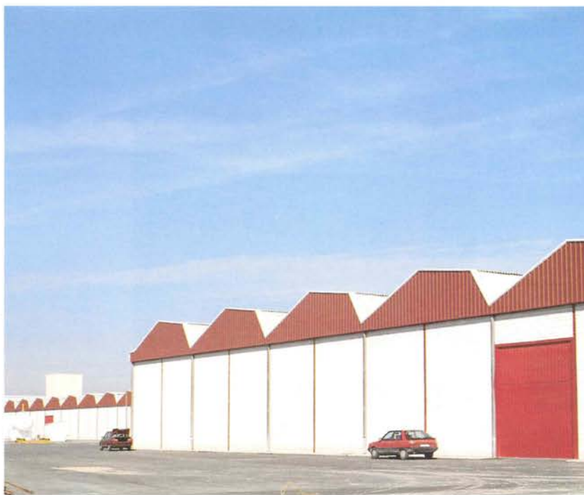
Instalaciones de PROELGA, S.A. (galletas SIRO) en el polígono industrial El Lomo. La empresa es una de las acogidas al Plan Z.U.R.
