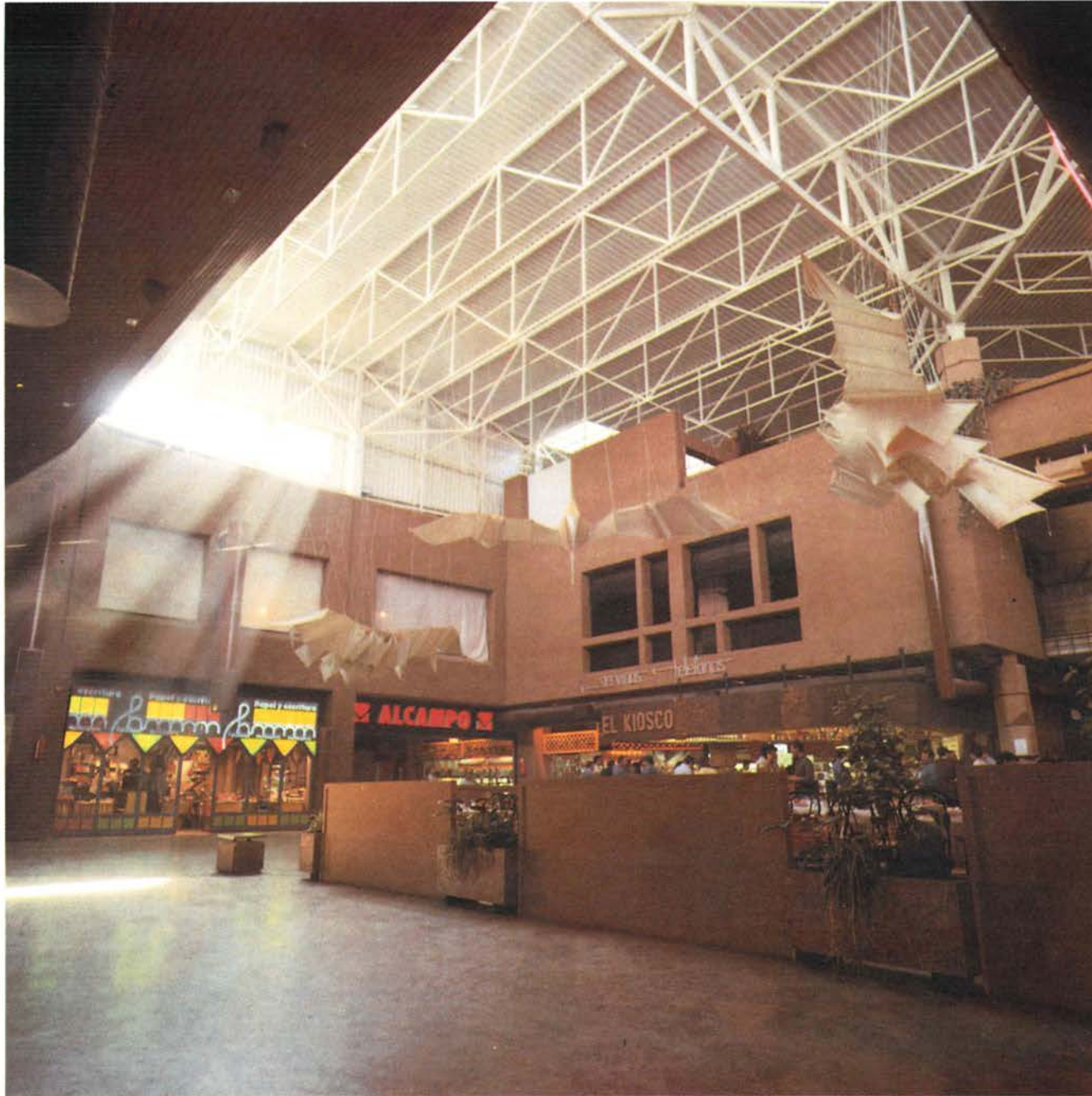
Interior del Centro Comercial del Sector 3, promovido por MERCASA.
