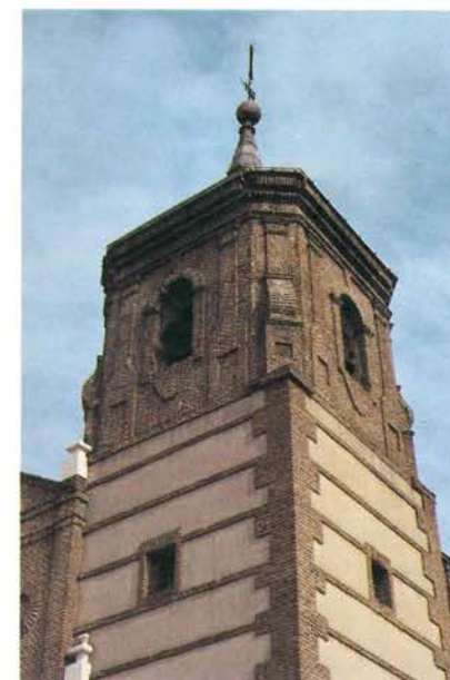
Torre de la ermita. Podemos apreciar la perfección de su acabado.
