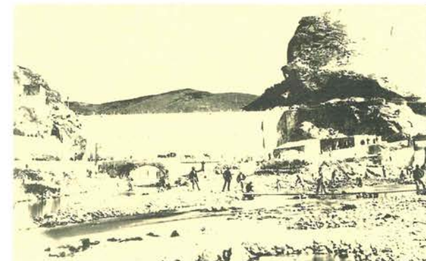
Construcción de la presa Pontón de la Oliva
