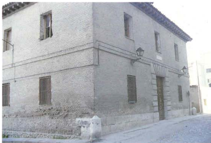
Antigua Cárcel del Partido Judicial. En la fotografía puede apreciarse el aspecto sencillo y simétrico de sus formas.
