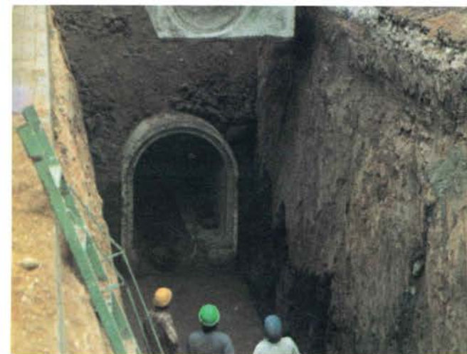
Construcción de uno de los grandes colectores.
