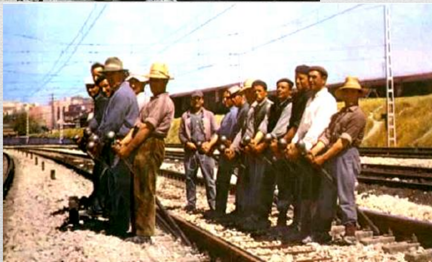
CUADRILLA DE VIAS Y OBRAS NIVELANDO RAILES
