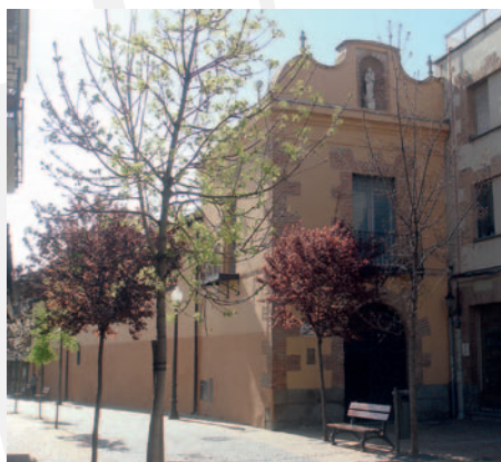
Fachada Hospital de San José.
